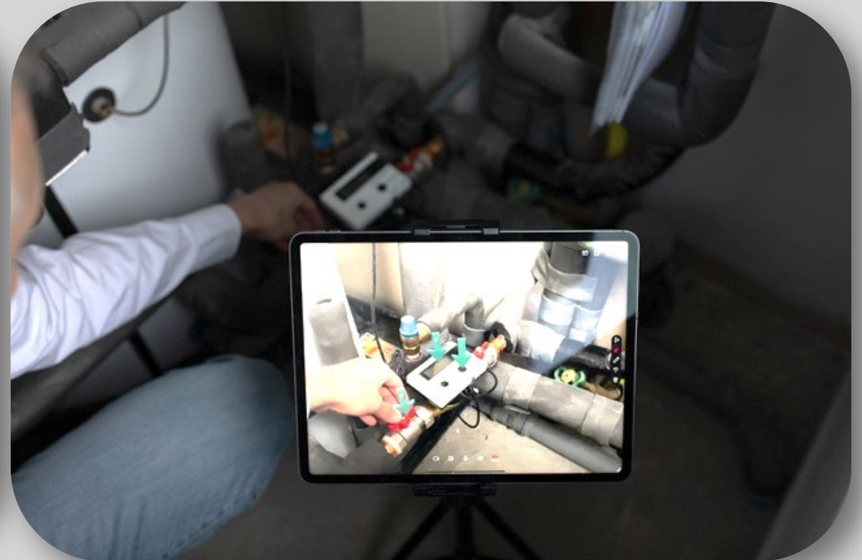
Die Ansicht auf der Baustelle
