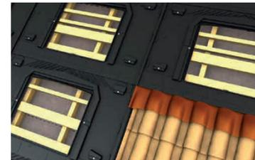
Die seitliche Verblechung auf die untere Wannenreihe montieren. Die anliegende Ziegelreihe wieder eindecken, so dass die seitliche Verblechung bedeckt ist.
